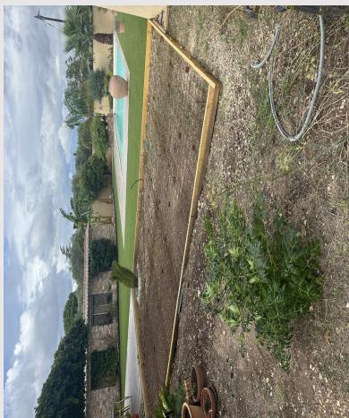
Coulage en direct d'une dalle extérieur \_\_Béton S4 conseillé \_\_Attention aux attentes même avec les goulottes nous n'arrivons pas au bout de l'ouvrage vu avec client \_\_Faire débarrasser l'accès à la dalle vu avec client \_\_Interdiction 5t5\_\_Environ 4m3
