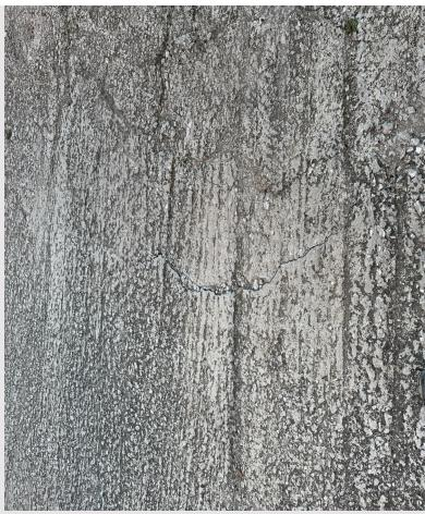
Coulage plage de piscine \_\_ Confirmer formule cubage cadence avec client \_\_ ATTENTION CONFIRMER LE TONNAGE sur cuers \_\_ Le chemin d'accès est betonné mais il est fissurer à plusieurs endroit, vu avec client de faire dégager notre responsabilité en cas de casse par rapport au poids de 32t d'un 8x4 au cas où nous cassons le béton \_\_ Prévoir protection des sols et une aire de lavage pour les toupie \_\_ Retour bac plein
